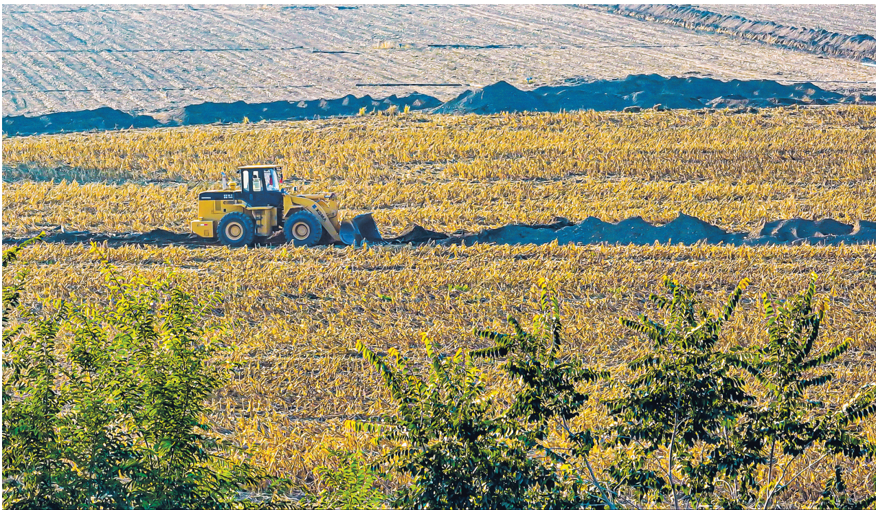
10月30日,在博乐市小营盘镇哈日莫墩村农田里,铲车正在填埋管道。近年来,我州积极推广浅埋滴灌高效农业节水技术,实施以农业节水为核心的高标准农田建设。今年,全州新建高标准农田8.67万亩(航拍图)。(记者楠登 摄)
